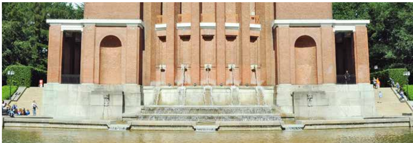
Die Beckenanlage nach der Sanierung mit Triflex .
