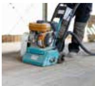
1. Sottoporre la superficie a fresatura e levigatura.
