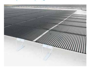
**Triflex ProSolar** è un sistema di rivestimento bianco che può migliorare notevolmente il grado di efficienza degli impianti fotovoltaici che vengono montati al di sopra. Il sistema può essere impiegato sia su impermeabilizzazioni funzionali esistenti, sia su impermeabilizzazioni nuove (per es. con Triflex ProTect).
