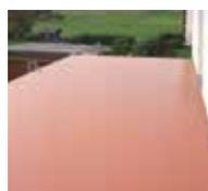
10. Infine viene applicato il sistema d'impermeabilizzazione Triflex BTS-P.
