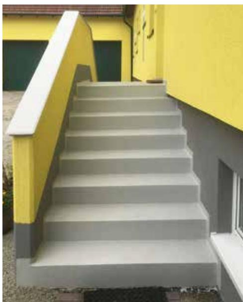
*Kreativ gelöst: Ein Balkonabschlussprofil sorgt am Handlauf dafür, dass Niederschlagswasser nicht länger an der Wand hinunterläuft, sondern gezielt abtropfen kann.*
