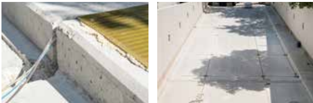
Einbau eines Freiflächenheizsystems
