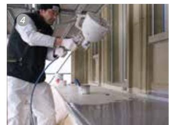
Auf den Balkon- und Terrassenflächen kommt das Abdichtungssystem BTS-P sowie das Beschichtungssystem BFS zum Einsatz. Alle Anschlüsse und Details wurden mit dem Abdichtungssystem Triflex ProDetail naht- und fugenlos integriert.
