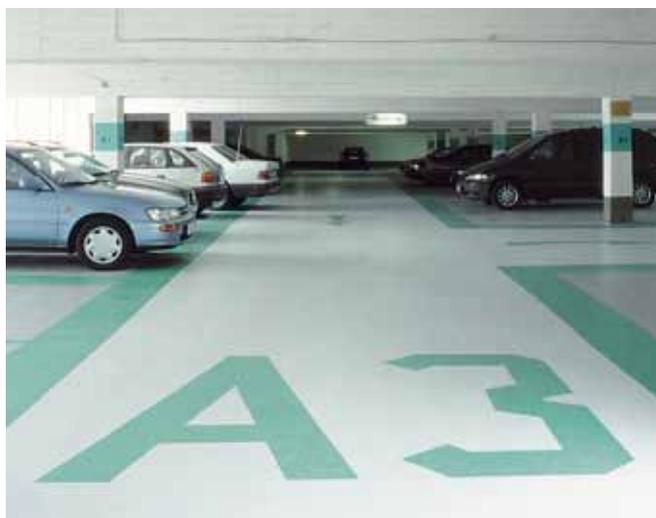
Triflex DeckFloor est un système de revêtement monocouche avec pontage statique des fissures. Ce mortier de nivellement supporte les fortes sollicitations mécaniques et est prévu pour les étages intermédiaires très fréquentés et aérés. À base de résine de polyméthacrylate de méthyle (PMMA), il peut également être employé pour les parkings en terrasse. Triflex DeckFloor est certifié OS 13 selon DAfStb Rili SIB 2005.
