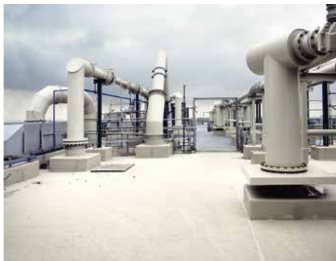
Les toits des silos étanchés garantissent le bon fonctionnement de la nouvelle centrale RWE de Westphalie.
