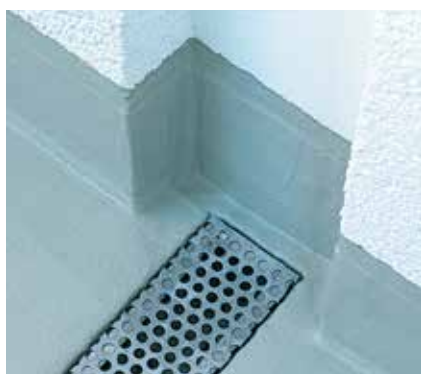
Balcon – Naissance et gouttière
