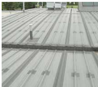
Toits plats – Toiture métallique
