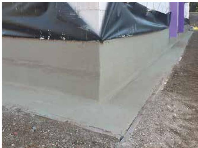
L'étanchéité de la construction commence par une exécution conforme des fondations. Un niveau élevé de la nappe phréatique et l'eau de pluie constituent les défis que doit pouvoir relever le matériau utilisé. La préservation durable du bâtiment n'est garantie que si les fondations et le soubassement sont également étanchés de manière fiable.
