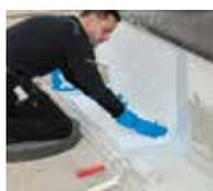
5. ...poser Triflex Voile de renfort PF en veillant à éliminer toutes les bulles, appuyer à l'aide d'un rouleau sec...
