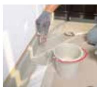
7. Étancher les raccords muraux et les détails avec Triflex ProDetail.
