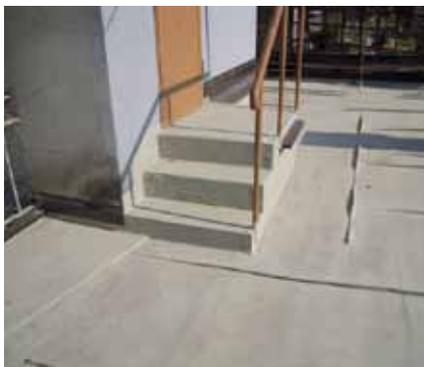
Anche l'impermeabilizzazione dei gradini è stata eseguita in tutta semplicità grazie al versatile sistema d'impermeabilizzazione per dettagli Triflex ProDetail.
