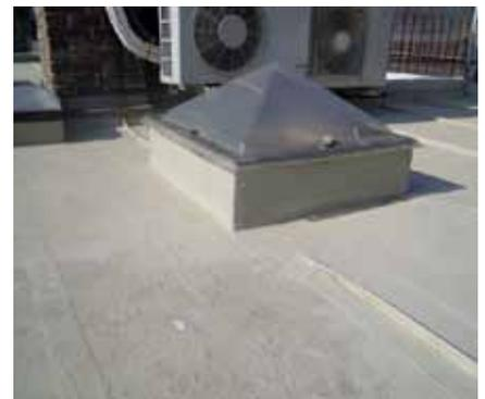
Fatto! La superficie del tetto è impermeabilizzata in modo duraturo e tutti i dettagli sono integrati senza saldature.
