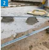
Il est également possible d'utiliser des coins en bois coupés qui seront retirés une fois la surface réalisée.
