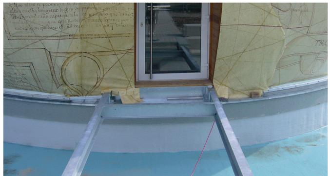
Mit dem hydrolysebeständigen System Triflex ProTect erfolgt die homogene Abdichtung wie aus einem Guss.
