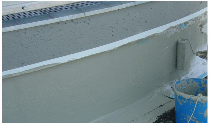
Für eine sichere Haftung auf dem Untergrund werden die angeschliffenen Asphaltflächen mit Triflex Cryl Primer 222 grundiert.
