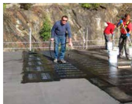
Prima di procedere con l'intervento d'impermeabilizzazione Triflex ProTect è stata ripristinata la coibentazione termica e la barriera a vapore.
