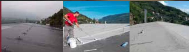
Risanamento della copertura esistente in guaina bituminosa eseguita con il sistema Triflex ProTect
