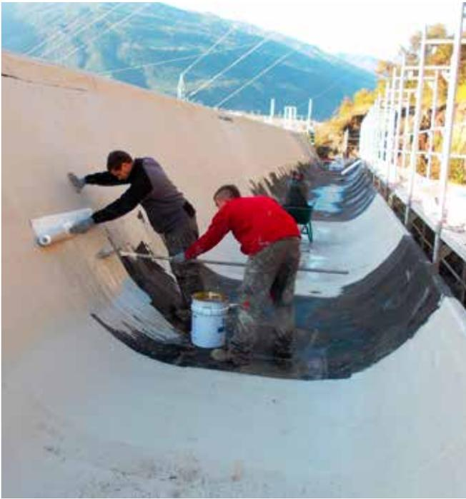
Anche porzioni di copertura complesse sono state impermeabilizzate con semplicità ed efficacia con il sistema ad adesione completa Triflex ProTect.
