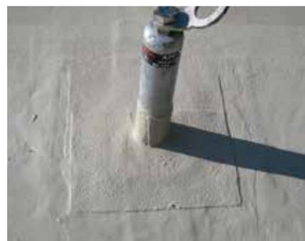
Per l'impermeabilizzazione dei 42 punti di ancoraggio della linea vita, è stato utilizzato il sistema d'impermeabilizzazione per dettagli ProDetail.
