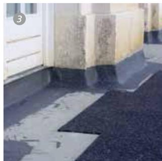
*Um die Bausubstanz des erdbe-rührten Fundaments zu schützen, wurde dieses mit Triflex Flüssig-kunststoff abgedichtet.*
