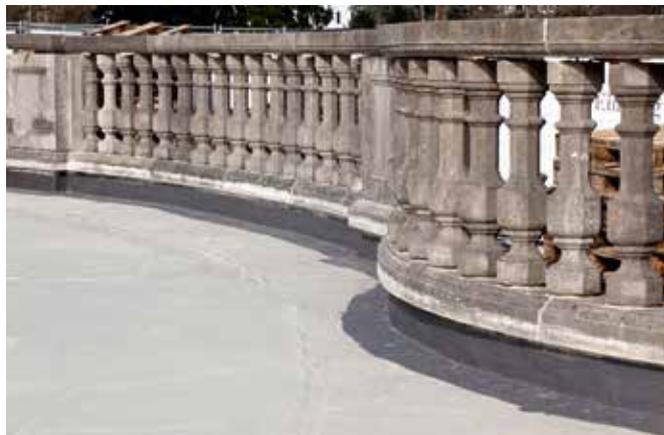
*Um die restaurierten, 200 Jahre alten Natursteinplatten später wieder auf der Terrasse verlegen zu können, musste die Fläche mit einer alkalibeständigen Systemlösung abgedichtet werden. Dafür erwies sich Triflex BWS auf Basis von Polymethylmethacrylatharz (PMMA) als optimale Lösung.*
