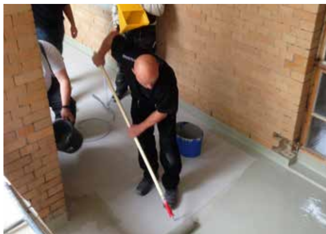
Zur Erhöhung der mechanischen Widerstandsfähigkeit erfolgte die Flächenversiegelung mit Triflex Cryl Finish 205 und Triflex Micro Chips.
