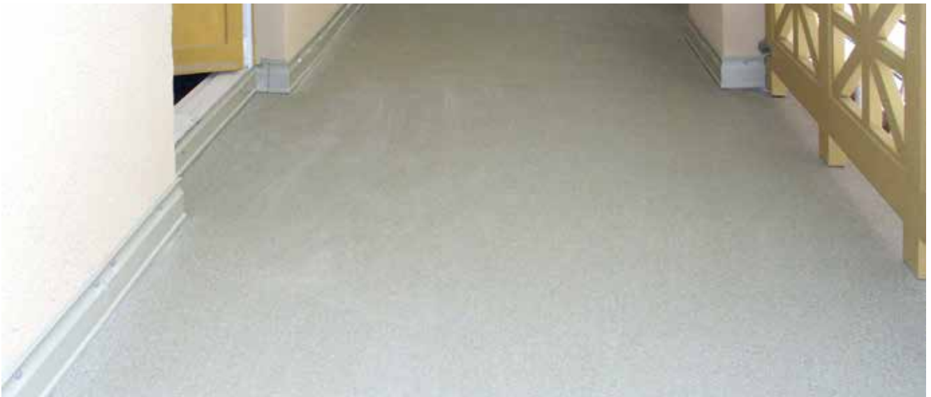
Das Kindertagesstätte nach der Sanierung mit Triflex
