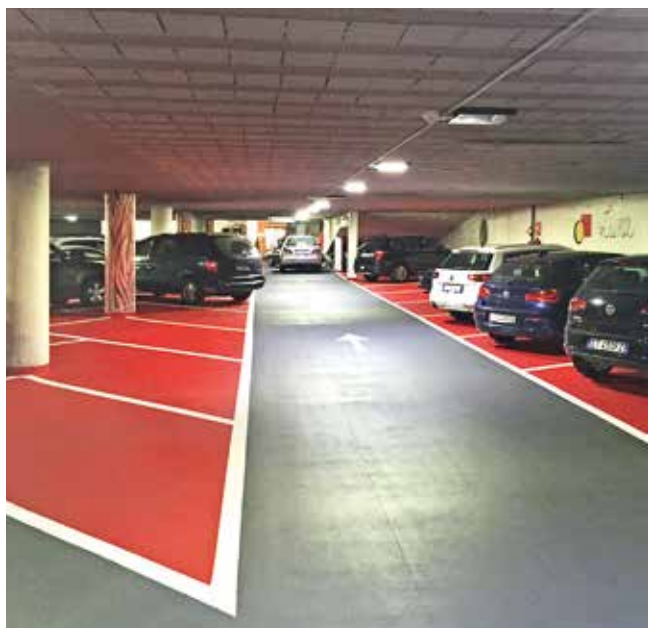
Garage sotterraneo per l'Hotel Mondschein, Bolzano
