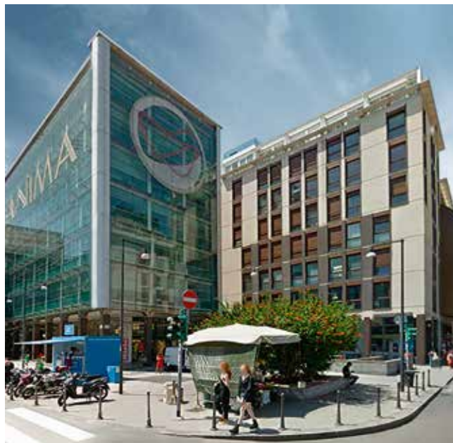
Galleria Commerciale, Milano
