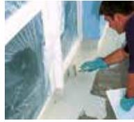
3. Zuerst werden die Details mit Triflex ProDetail abgedichtet.
