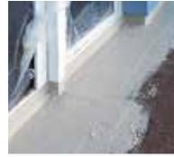
5. Eine zweite Schicht Triflex ProDetail wird aufgebracht.
