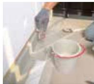
7. Wandanschlüsse und Details werden mit Triflex ProDetail abgedichtet.
