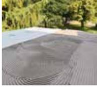
2. Der Kleber Triflex ProDrain Fix+ wird in zwei Lagen aufgetragen ...
