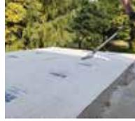
4. Die Bahn wird mit einer Andrückwalze vollflächig verklebt.
