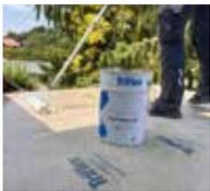
5. Durch das satte Grundieren mit Triflex Ceryl Primer 276 erhält die Entkopplungsbahn seine Steifigkeit.
