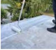
1. Untergrund vorbereiten, mineralische Untergründe werden mit Triflex ProDrain Primer grundiert.
