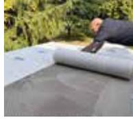
3. ... und anschließend die Triflex Entkopplungsbahn DC-Mat ausgerollt.
