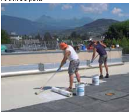
Si è quindi provveduto a impermeabilizzare la superficie con Triflex ProTect...
