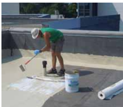
... e a integrare i dettagli impermeabilizzati nella superficie.
