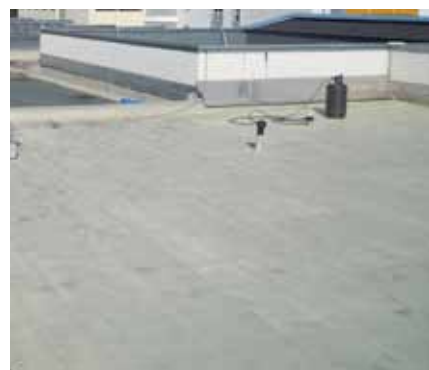
Dopo il risanamento con Triflex: il tetto risulta impermeabilizzato con una superficie priva di saldature e giunzioni per una protezione a lungo termine.
