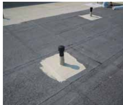
Durante il risanamento: gli esecutori impermeabilizzano innanzitutto i dettagli con Triflex ProDetail.
