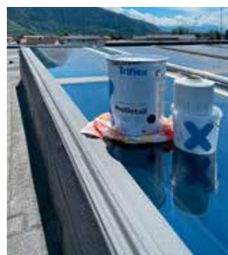
„FÜR DIESE ANFORDERUNGEN ERWIES SICH TRIFLEX PRODETAIL ALS OPTIMALE LÖSUNG. DAS AUF PMMA-BASIERTE FLÜSSIGKUNSTSTOFF-SYSTEM SCHMIEGT SICH WIE EINE ZWEITE HAUT SELBST UM KOMPLEXE GEOMETRIEN UND HAFTET VOLLFLÄCHIG, WODURCH EINE HINTERLÄUFIGKEIT VERHINDERT WIRD.“
