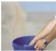
11. Für feste Fremdbeläge wird die Nuttschicht mit Quarzsand abgestreut.
