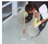
10. Die Nuttschicht Triflex ProTerra wird auf der Fläche aufgebracht.
