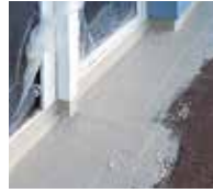
5. Eine zweite Schicht Triflex ProDetail wird aufgebracht.
