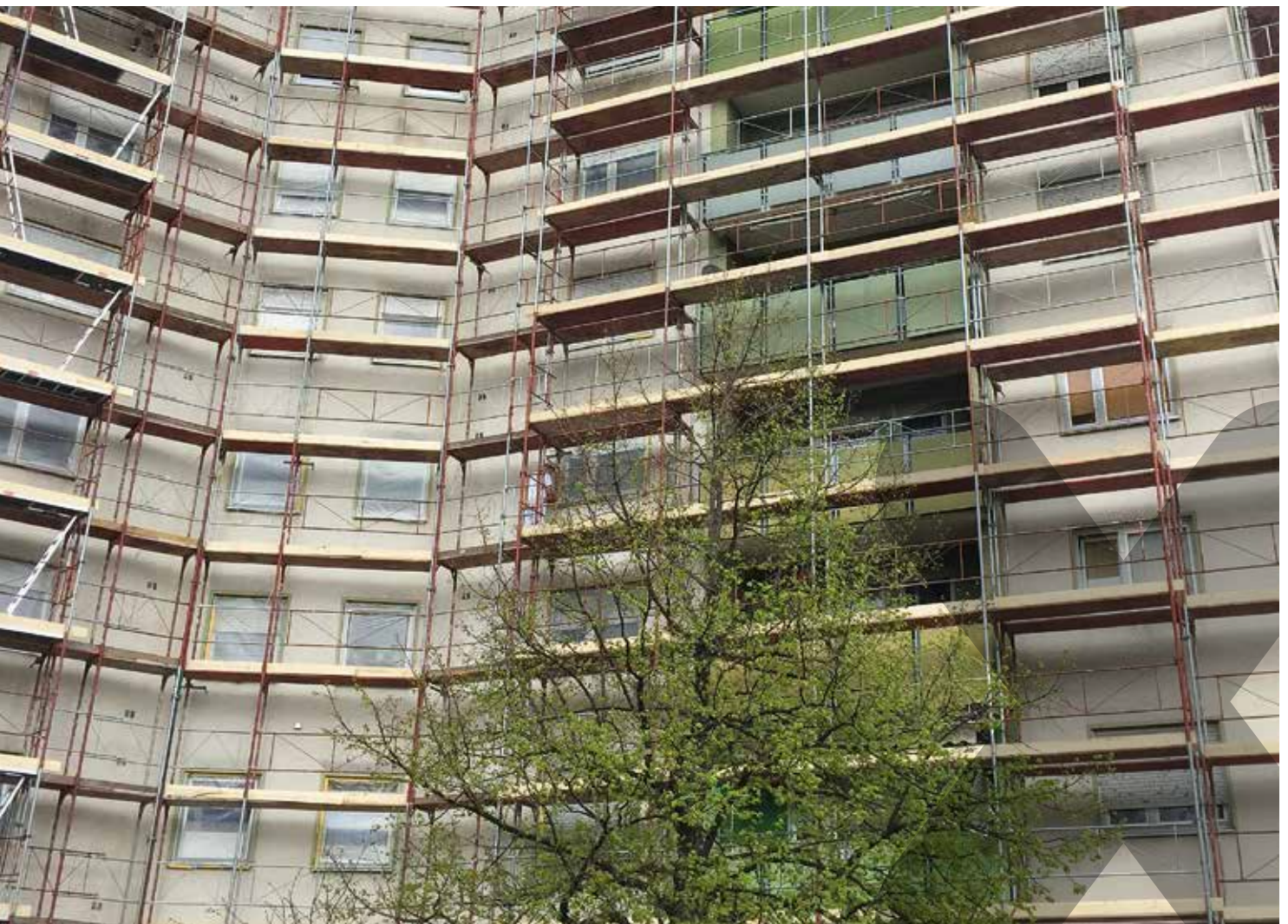
BALKONE | TERRASSEN | LAUBENGÄNGE
