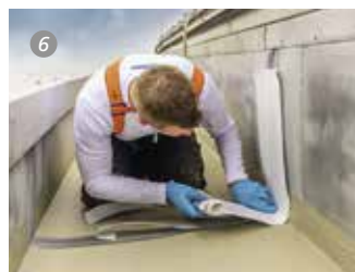
2. Für die Grundierung der Fläche sowie der 126 lfdm Dehnungsfugen setzten die Sanierer Triflex Metal Primer ein. Foto: Triflex
