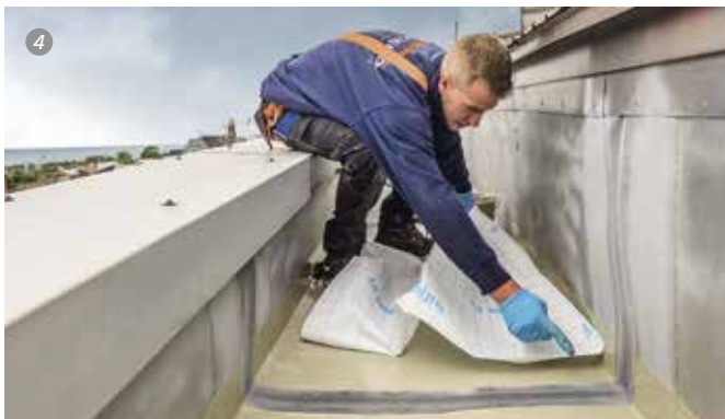
1. In einem ersten Arbeitsschritt haben die Verarbeiter der DADEGO Dachdecker-Genossenschaft Bremen eG die 232 lfdm Aluminium-Rinne gereinigt und vorbereitet. Foto: Triflex
