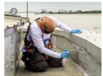
4. Das Spezialvlies wird in das noch flüssige Harz eingelegt und mit einer weiteren Schicht PMMA bedeckt. Foto: Triflex
