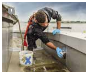
Durch die umlaufende Regenrinne des Klimahauses Bremerhaven war Feuchtigkeit hinter die Dachhaut gelangt und hatte die Dämmung beschädigt. Deshalb war eine neue Abdichtung erforderlich. Foto: Triflex
