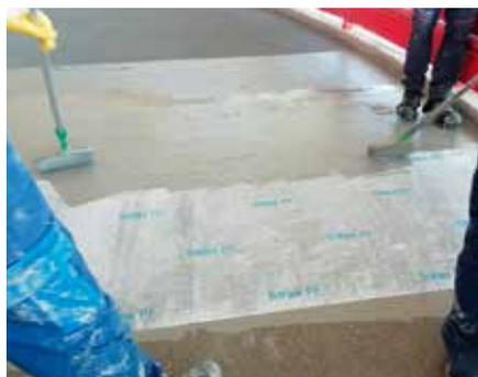
Im Systemaufbau des PMMA-basierten Triflex ProPark ist eine Spezialvlieseinlage vorgesehen, die in zwei Schichten des flüssigen Harzes eingebettet wird.
