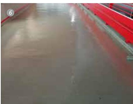
Die Versiegelung Triflex Cryl Finish 209 erhöht die chemische und mechanische Widerstandsfähigkeit der Abdichtung. Ebenso wie die anschließende Endbeschichtung wurde sie im Farbton Steingrau ausgeführt.
