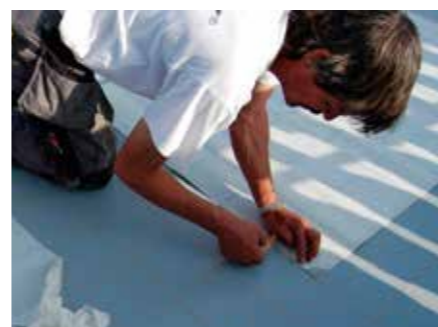
Ausrichten und Fixieren der Triflex Design Folie am Mauerwerk. Sorgfältiges Andrücken aller Fugen der Klebefolie. Abziehen der oberen Trägerfolie.
