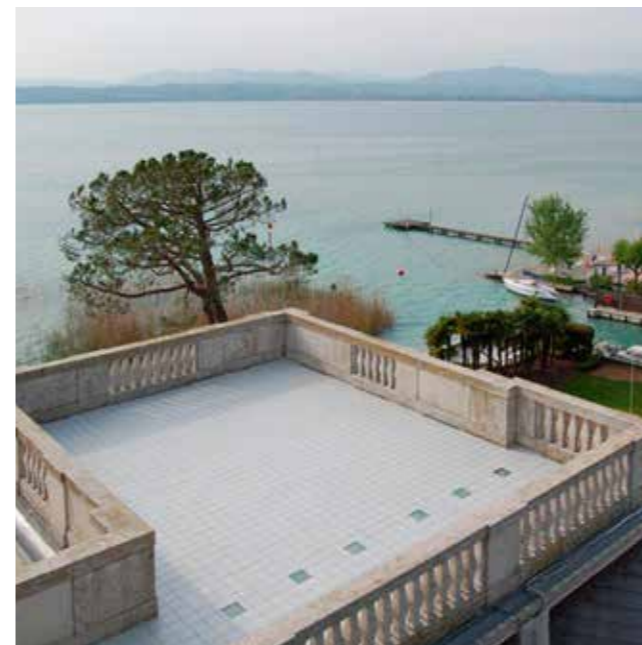
Da die Optik der Balkonoberfläche unverändert bleiben sollte, kam Triflex Creative Design, das System zur kreativen Balkon- und Terrassengestaltung zum Einsatz.
