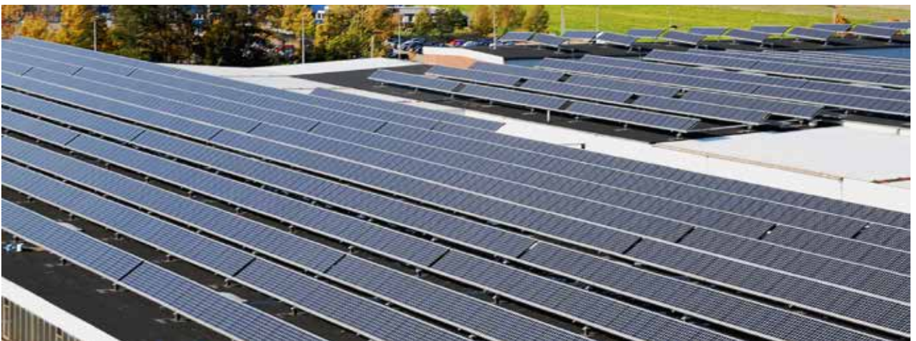
Das Solardach nach der Sanierung mit Triflex ProTect .
