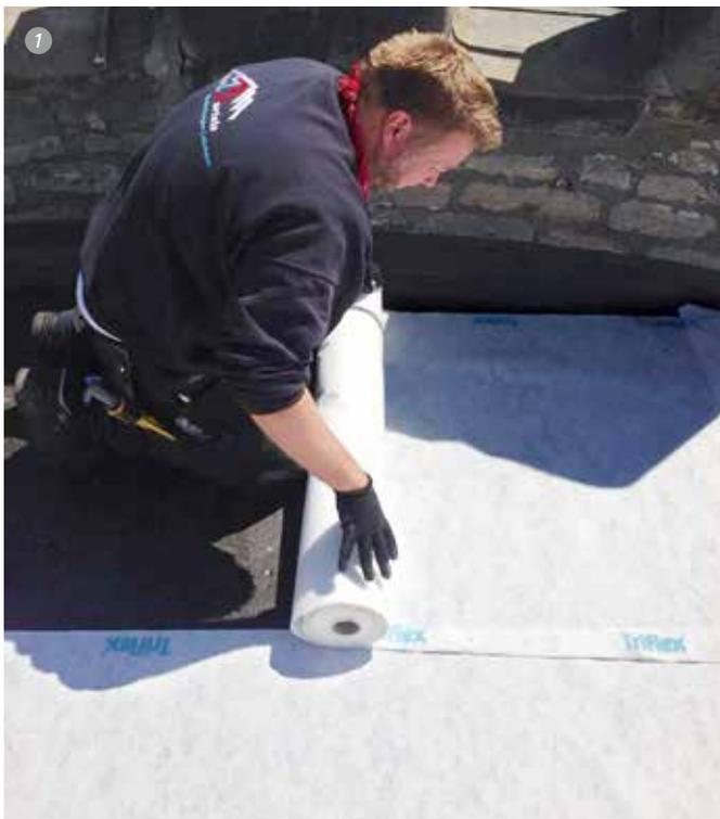
Ohne Lufteinschluss legt der Verarbeiter das **Triflex Spezialvlies** in das satt vorgelegte, flüssige Harz auf PMMA-Basis ein und drückt es falten- und hohlraumfrei an.
