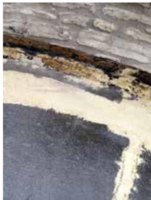
Unebenheiten der Oberfläche glichen die Handwerker mit **Triflex Cryl Spachtel**, einer 2-komponentigen, pigmentierten Spachtelmasse auf PMMA-Basis, aus.
