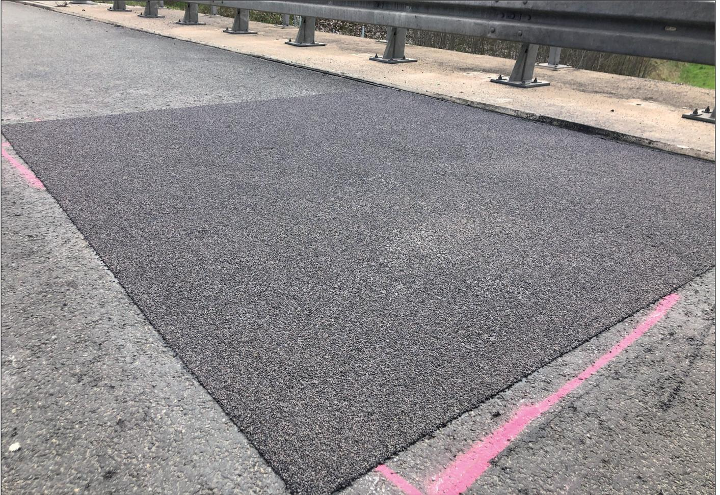
Abbildung 1.2.1: Wiederhergestellte Asphaltdeckschicht nach einem Brandereignis Quelle: Triflex
