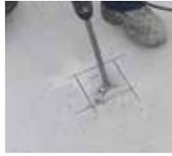
2. Ausbrüche und Schlitze für Verteilerdosen, Sensoren und Kabel werden eingefräst.
