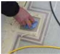
6. Anschließend werden der Eis- und Schneensensor sowie der Temperaturfühler eingesetzt.
