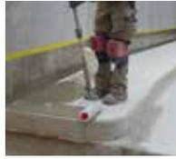
3. Anschließend wird mit Triflex Ceryl Primer 287 zweimal grundiert und abgesandet.
