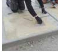
4. Triflex HeatTec Kleber EP wird mit dem Zahnpachtel vollflächig aufgebracht...
