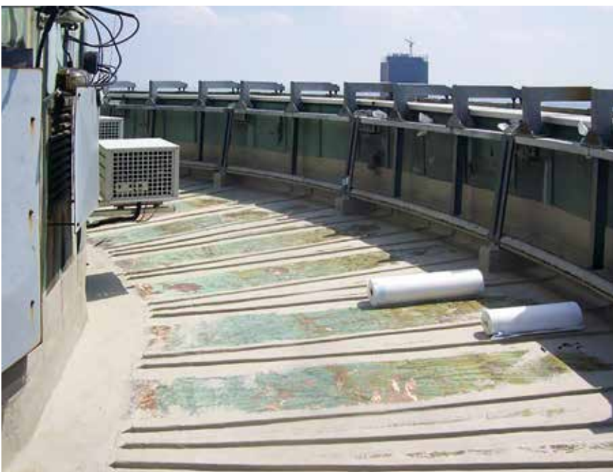
In einem ersten Schritt wurden Details wie Stehfälze vliesarmiert abgedichtet.
