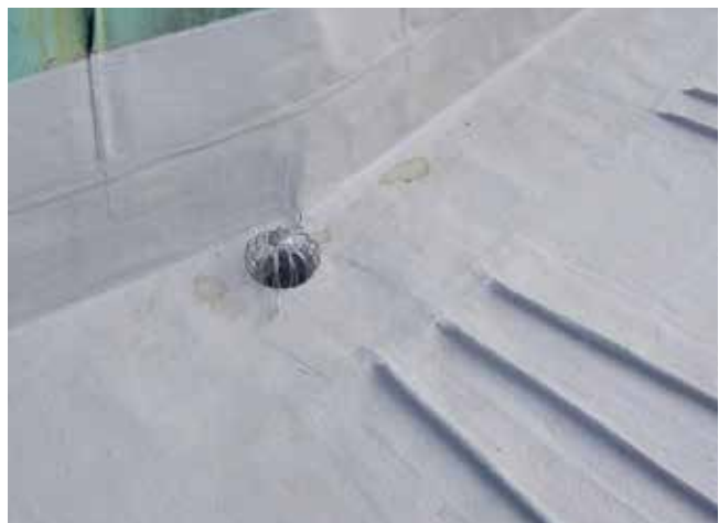
Auch Abflüsse und Wandanschlüsse dichtet Triflex Flüssigkunststoff homogen und langzeitsicher ab.
