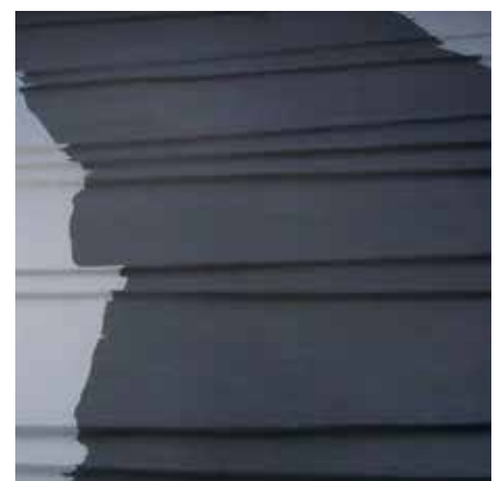
Aufgänge und Anschlüsse bindet das thixotropierte Harz homogen in die Abdichtungsfläche ein.
