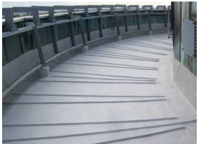
Dauerhaft dicht schützt das abgedichtete Kupferdach Turmkorb und Schaft des Aussichtsturms vor eindringender Feuchtigkeit.
