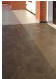
Il primer a reazione rapida è pronto per la lavorazione successiva già dopo 45 minuti.
