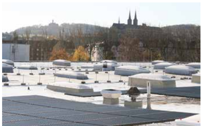
Bei der Sanierung des Daches der Stadtwerke Bamberg mit anschließender Montage der leistungsfähigen Solyndra Photovoltaikanlage kommen die Stärken des hochwertigen und langlebigen Abdichtungssystems Triflex ProTect zum Einsatz. Aufgrund der Widerstandsfähigkeit gegenüber mechanischen und klimatischen Belastungen dichtet der nach ETAG 005 zugelassene Flüssigkunststoff die ebene Dachfläche dauerhaft sicher ab und bietet gleichzeitig mit seiner Versiegelung im Farbton rein weiß einen thermisch unempfindlichen, Sonnenlicht abstrahlenden Untergrund zur umweltfreundlichen Energiegewinnung.
