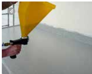
Die Flächenbeschichtung Triflex ProFloor S1 wird vollflächig aufgetragen und ist bereits nach circa einer Stunde überarbeitbar. Die Wandanschlüsse sowie weitere Details werden für die Versiegelung der gesamten Fläche vorbereitet. Die Versiegelung mit der schwer entflammablen Sonderlösung Triflex BFS S1 sorgt dauerhaft für erhöhten Brandschutz auf den Balkonen. Für optisch ansprechende Oberflächen werden zum Abschluss Triflex Micro Chips per Trichter-pistole in die frische Versiegelung eingeblasen.
