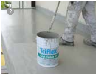
Die Flächenbeschichtung Triflex ProFloor S1 wird vollflächig aufgetragen und ist bereits nach circa einer Stunde überarbeitbar. Die Wandanschlüsse sowie weitere Details werden für die Versiegelung der gesamten Fläche vorbereitet. Die Versiegelung mit der schwer entflammablen Sonderlösung Triflex BFS S1 sorgt dauerhaft für erhöhten Brandschutz auf den Balkonen. Für optisch ansprechende Oberflächen werden zum Abschluss Triflex Micro Chips per Trichter-pistole in die frische Versiegelung eingeblasen.
