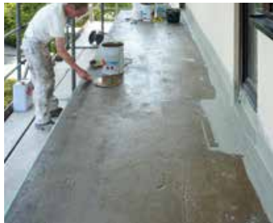
Nach der Instandsetzung des Betonbodens erfolgt die Grundierung mit Triflex Cryl Primer 276. Vor dem Auftragen der Flächenbeschichtung werden alle Details wie Türanschlüsse, Stirnflächen und Tropfkanten mit Triflex ProDetail abgedichtet.
