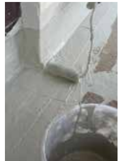
Nach der Instandsetzung des Betonbodens erfolgt die Grundierung mit Triflex Cryl Primer 276. Vor dem Auftragen der Flächenbeschichtung werden alle Details wie Türanschlüsse, Stirnflächen und Tropfkanten mit Triflex ProDetail abgedichtet.
