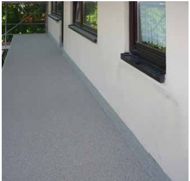
Dauerhaft dicht und mit einer flammhemmenden Beschichtung geschützt präsentieren sich die Balkone nach der Sanierung.
