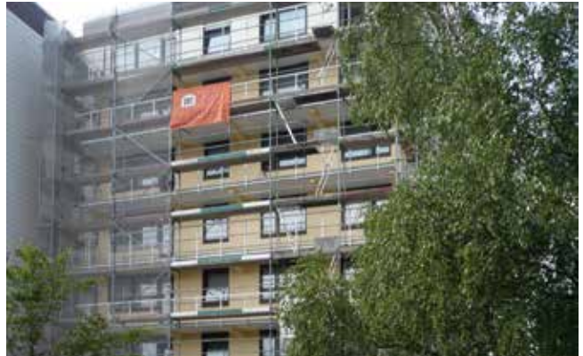
Die SBS Special-Bautenschutz-Service-GmbH aus Mülheim an der Ruhr wurde mit der Sanierung beauftragt und entschied sich für das Balkon Beschichtungssystem Triflex BFS S1.
