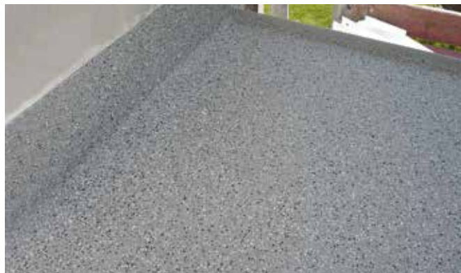
Dicht bis ins Detail sind die fertigen Balkone in Ratingen nach der Sanierung.
