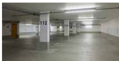
Die Zwischendecks wurden mit dem Abdichtungssystem Triflex ProPark, Oberflächenvariante 2 ausgeführt.
