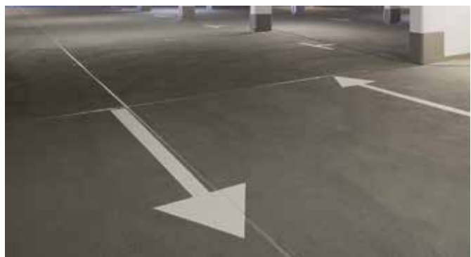
Die Zwischendecks wurden mit dem Abdichtungssystem Triflex ProPark, Oberflächenvariante 2 ausgeführt.
