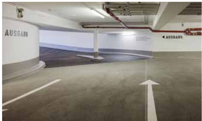
Die Ein- und Ausfahrtrampen wurden mit dem Abdichtungssystem Triflex ProPark, Oberflächenvariante 3 ausgeführt.
