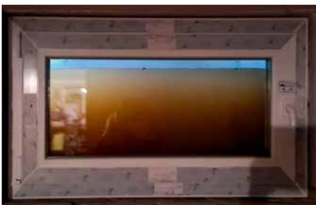
Nach der Sanierung ist der Kellerschacht mit Regenwasser vollgelaufen. Fenster sowie die Abdichtung halten dem Druck stand.
